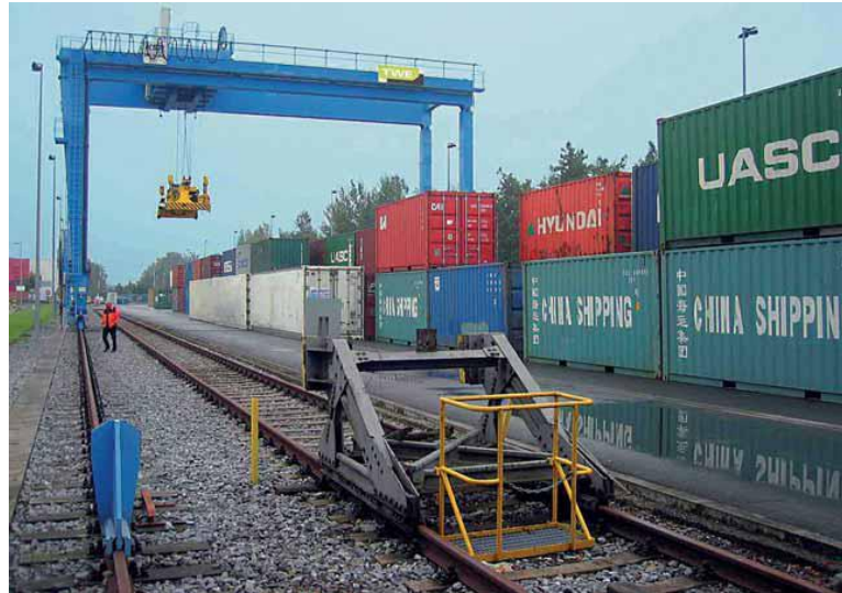
Abbildung 11: Krananlage im Terminal Gütersloh 143
